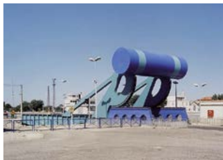
Port-Saint-Louis-du-Rhône (13), pont mobile
