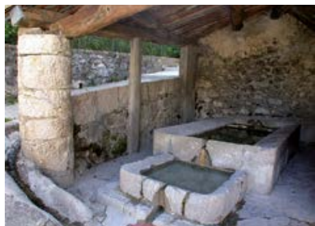
Soleilhas (04), fontaine et lavoir
