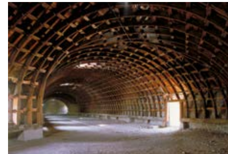
Mont-Dauphin (05), charpente de la caserne Rochambeau
