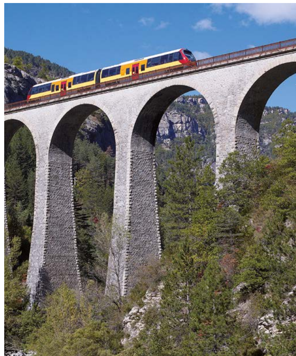
Saint-Benoît (04), viaduc ferroviaire de la Donne
