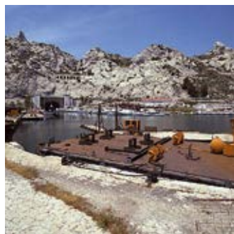
Marseille (13), port et digue de la Lave, entrée du tunnel du Rove
