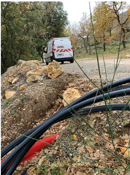
Enfouissement partiel quartier Notre Dame – Travaux commun NCA
