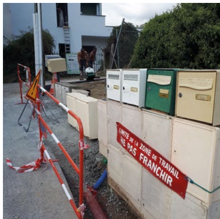
Enfouissement vieille route de Carros – Vallon de l'Aspre
