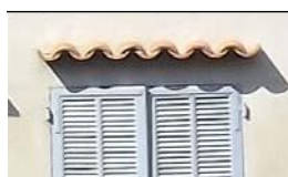
Rangs de tuiles au-dessus des linteaux proscrits
