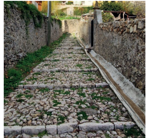
Canal d'irrigation le long de la descente des Moulins
